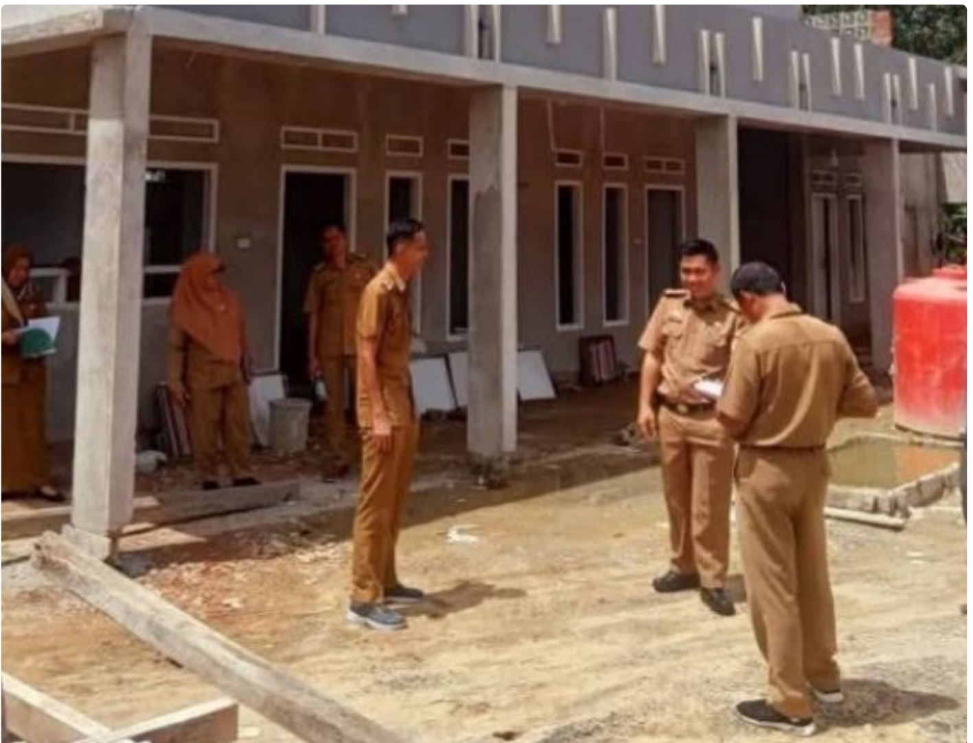
Kepala Bidang Tata Ruang, Afid Sudyanto, ST., bersama Bidang Bangunan Gedung melakukan survey lapangan bersama Tim Forum Penataan Ruang Kabupaten Mesuji
